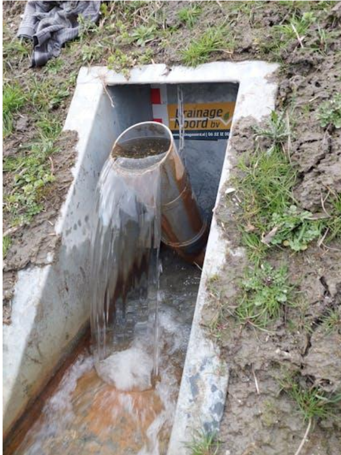
Figuur 10 Emondsbak met in hoogte verstelbare overstortpijp
